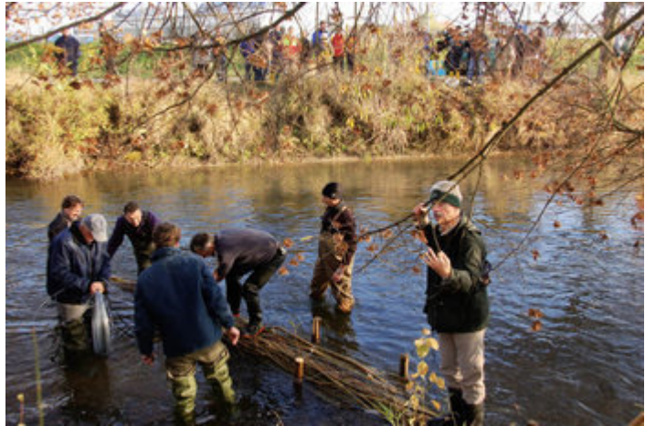
Den Kursteilnehmern des Gewässertags am gegenüberliegenden Ufer wurde der Bau einer Bühne demonstriert. | Foto: Alfred Peter
