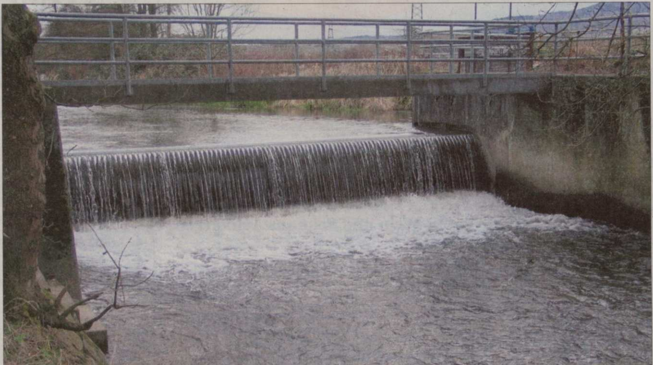
Nicht immer führt die alte Dreisam so viel Wasser, denn die automatisch gesteuerte Fischbauchklappe sichert der Adlermühle in Bahlingen einen Mindestzufluss, rechts hinter dem Steg.
