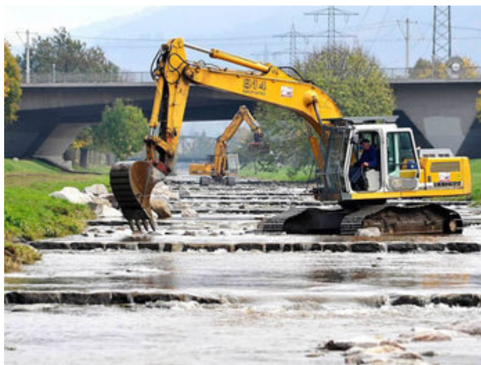
Damit die Fische besser wandern können, wird in der Dreisam gebaggert. | Foto: Thomas Kunz
