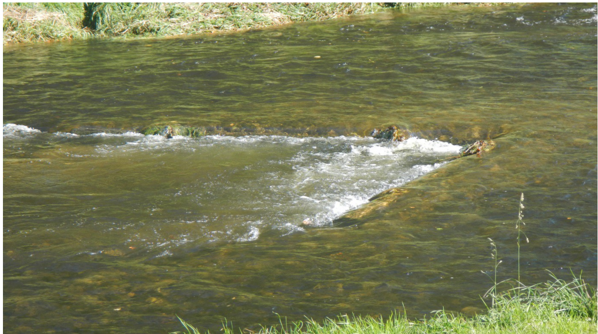
V-Schwelle mit Auskolkung
